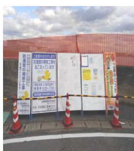
①電柱改修工事
